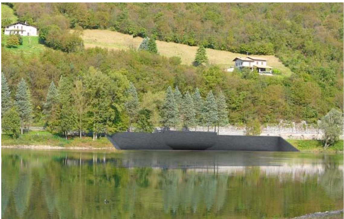
Fig. 13: alternativa con soglia a 367,20 m s.m. di 100,0 m e paratoie all'imbocco della galleria
