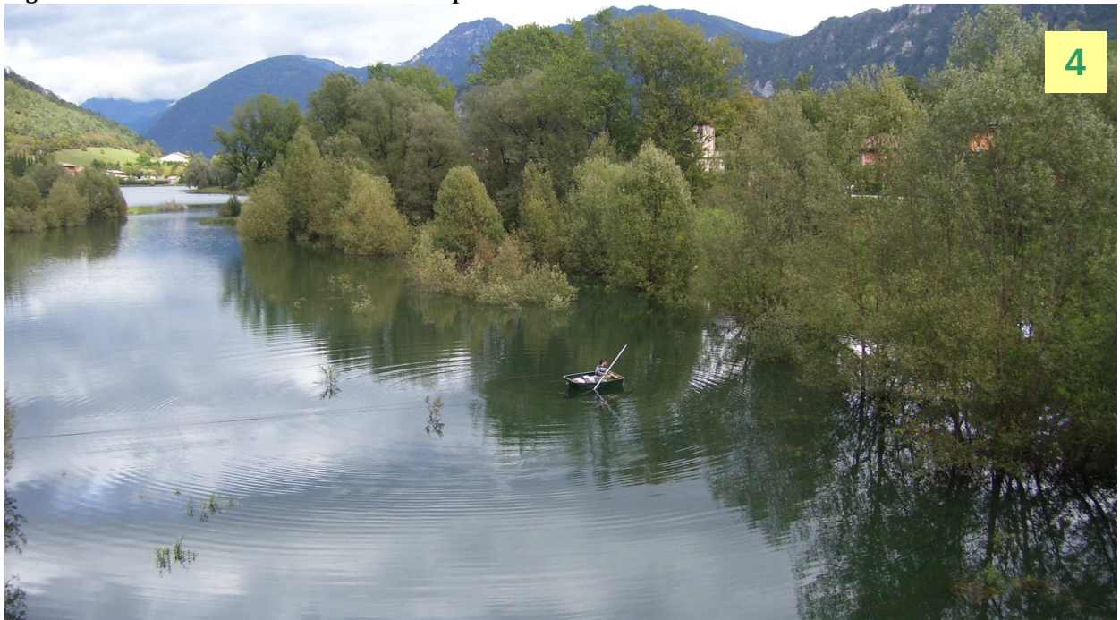
Figura 5-35: Panoramica verso monte dalla ponte stradale esistente
