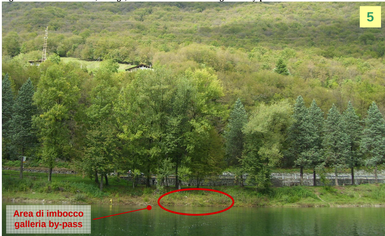
Figura 5-36: Vista frontale, da lago, dell'area d'imbocco della galleria by-pass
