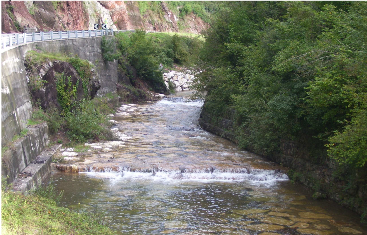
Figura 5-17: L'alveo del Fiume Chiese a valle della traversa di Idro.
