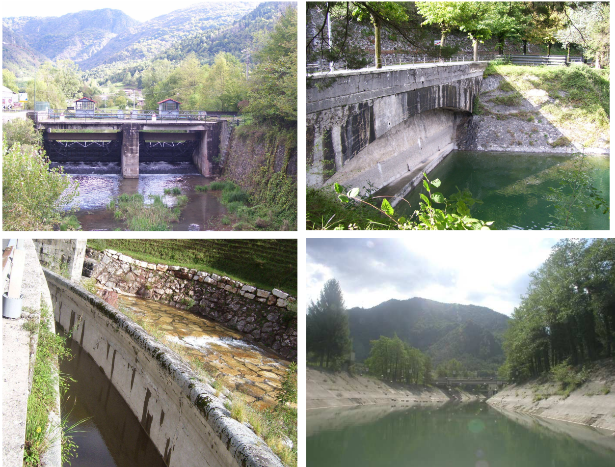
Figura 3-3: Le opere di regolazioni esistenti, da sinistra in alto procedendo in senso orario si osserva: la traversa di sbarramento, l'imbocco della galleria di svaso e lo sbocco
