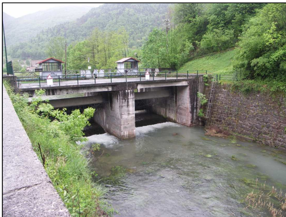
Traversa vista da valle
