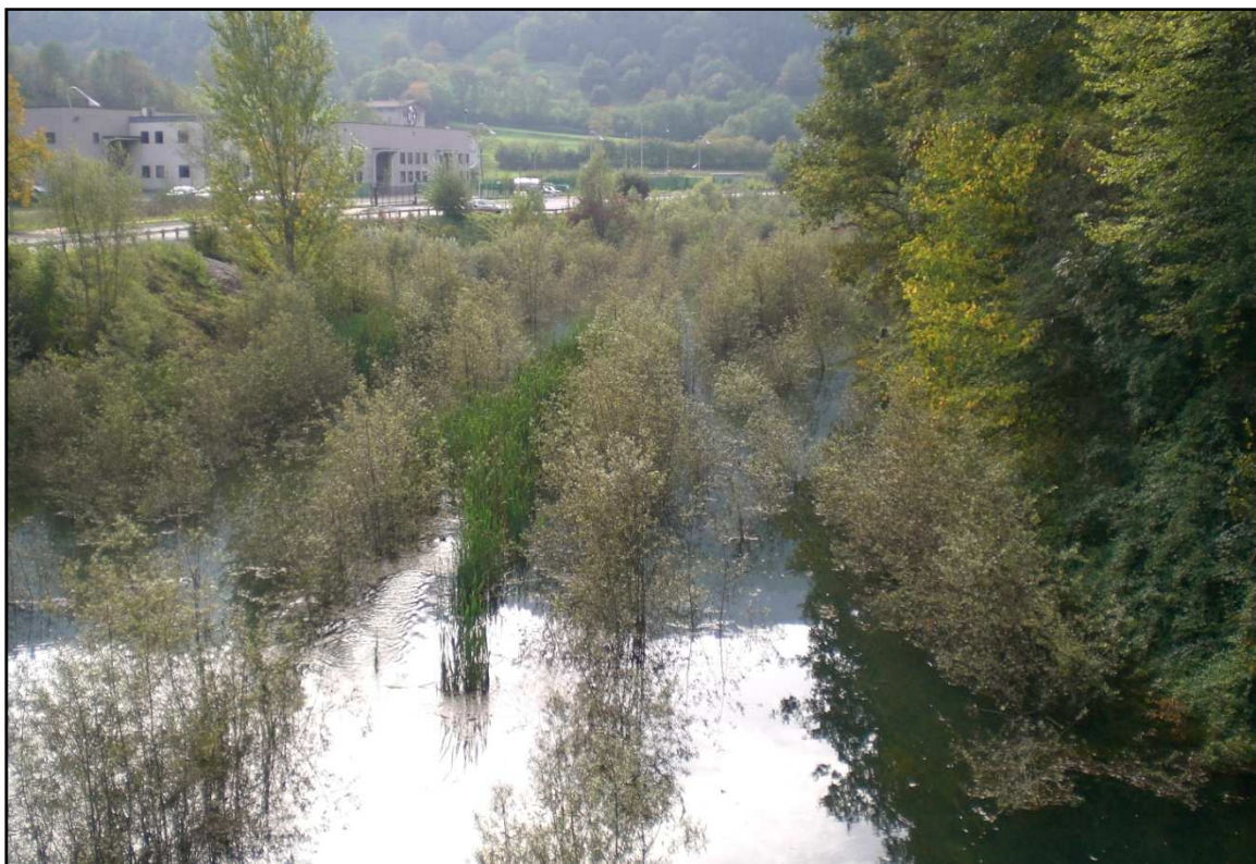
Area interessata dalla nuova traversa e lavori in alveo
