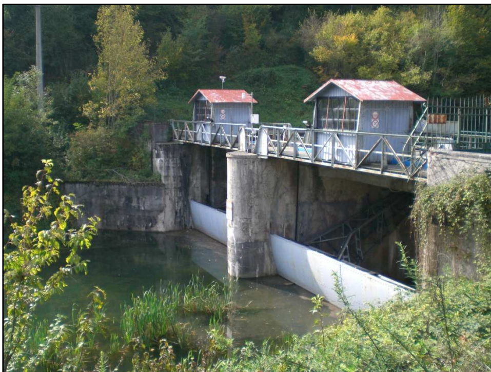
Traversa vista da monte
