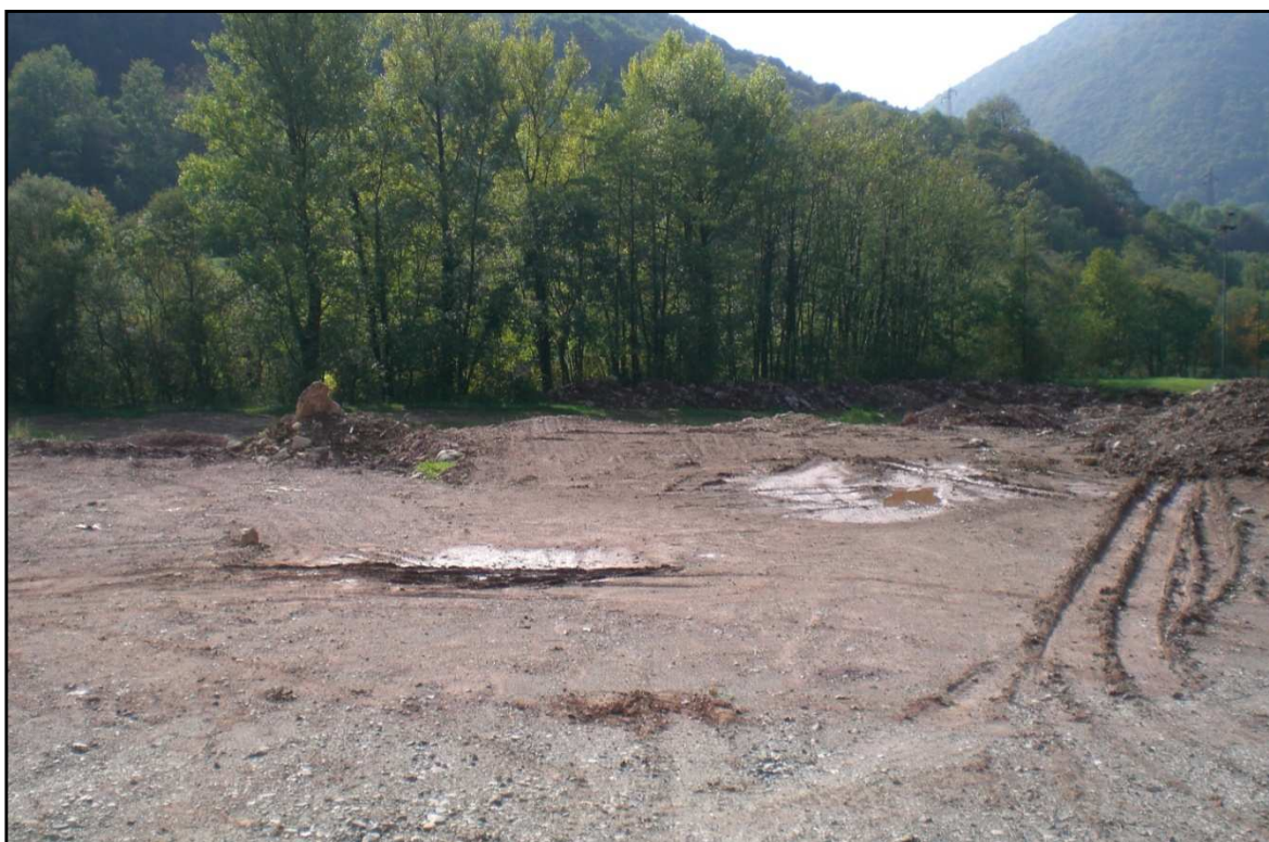
Area interessata dal passaggio canale di restituzione in Comune di Lavenone
