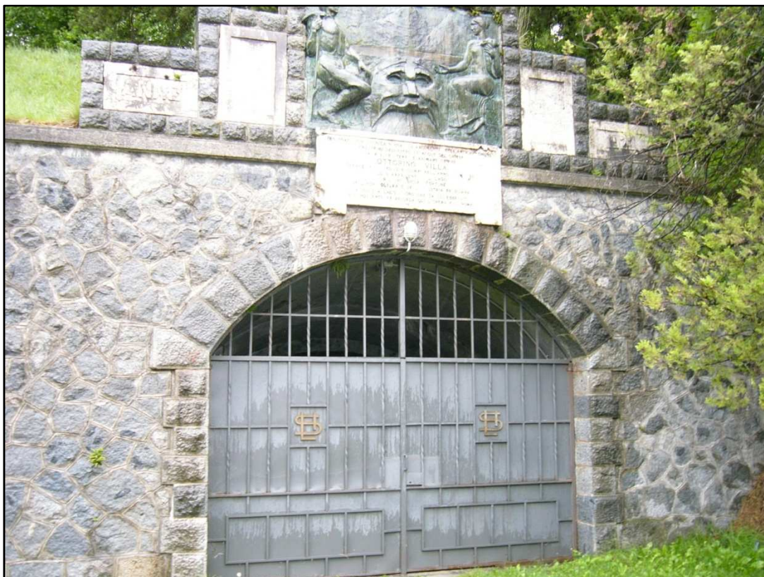
Portale del cunicolo di accesso alla camera paratoie
