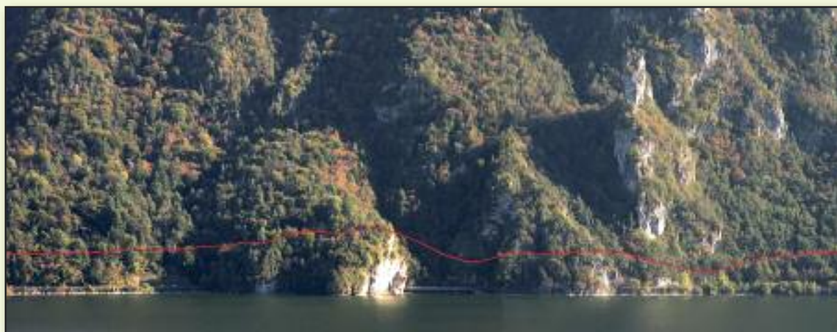
Parte del percorso pedonale bypass gallerie, da recuperare
