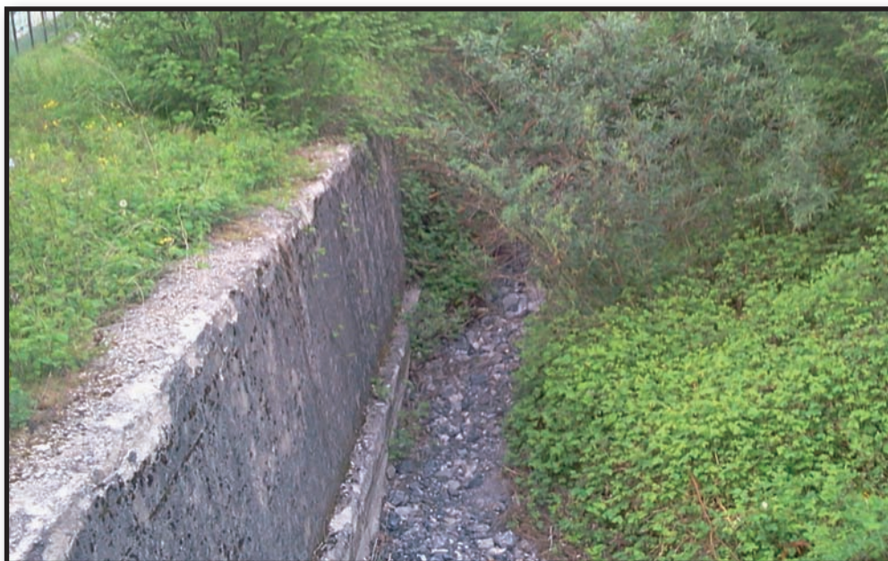
Torrente Neco prima dell'intervento
