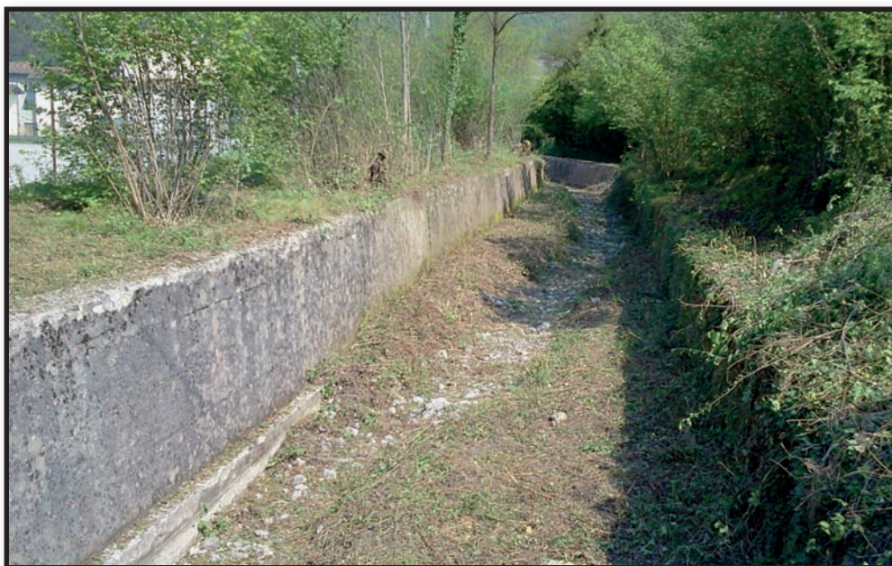
Torrente Neco dopo l'intervento
