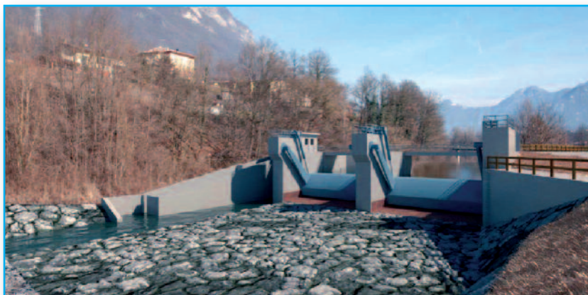
Nuova traversa di sbarramento - vista da valle.
