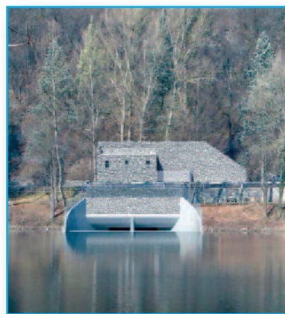
Opere di imbocco galleria.
